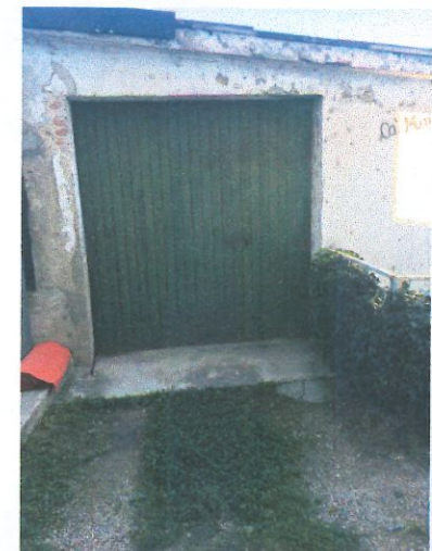
PARTICOLARE ACCESSO AL BOX/AUTORIMESSA
