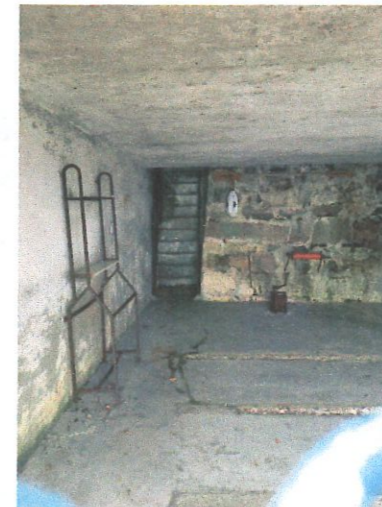
VISTA INTERNA DELLA DARSENA
